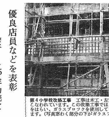
第4小学校改築工事 工事は木工工事で、左官などの仕上げの点に注意を払っています。この改築工事は、ガラスブロックを使用し、校舎内を明るくしています。(写真真ん中部分の下がガラスブロック)
