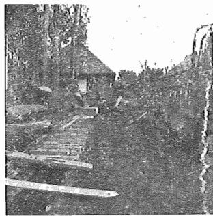
(改修中の都部地先)
