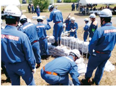
土のうづくりや青竹を使って堤防の亀裂拡大を防ぐ「折り返し工法」、漏水を防ぐ「月の輪工法」などの伝統的な工法を行います。また、国土交通省の災害対策用機械の展示も行います。
