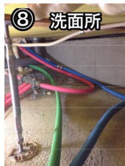
ヘッダー廻りの給水配管 [床下騒音発生現場 (竣工後3年)]
