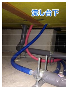
ヘッダー廻りの給水配管 [床下騒音発生現場 (竣工後3年)]
