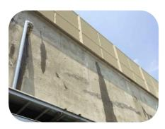
図 5-3.湖北台浄水場ろ過原水ポンプ井漏水跡
