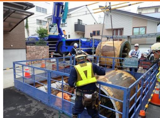
雨水管布設時の状況（推進工法）
