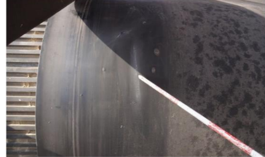
図 2.5 水平ベルトコンベヤ (ベルト亀裂)
