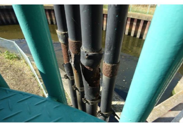
図 2.9 ゲート操作盤 (屋外配管)
